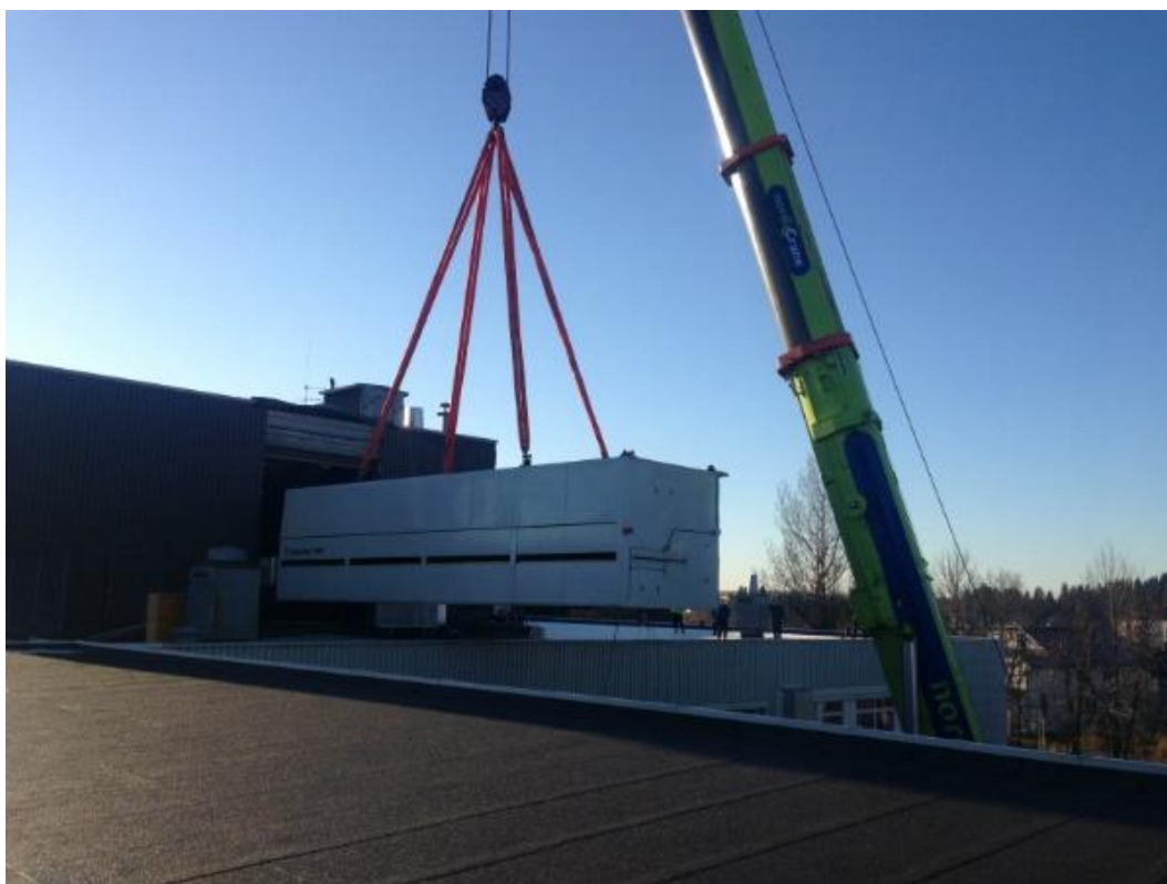
Ny trykkpresse i Polaris Trykk Trondheim Polaris Trykk Trondheim har i 2014 installert ny trykkpresse med tørker, som muliggjør mer kostnadseffektiv produksjon og trykking på glanset papir. Bildet viser tørker på over 40 tonn som heises inn gjennom midlertidig hull i veggen på pressehallen. Foto: Frode Sandmark
