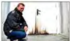
Brann Brannvesenet var raskt på staden i Sør-Vågskyrkje etter brannen.
