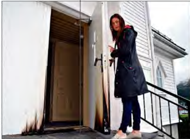
Brann Røyk og skadegjering etter brannen i Sør-Vågskyrkje. Anne-Gry Fløien jobber med å få oversikt over skadene i Sør-Vågskyrkje etter at roken hadde satt fyr på den natt til laurdag.
