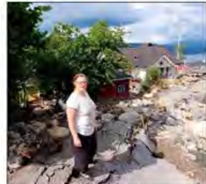
TRULSØY (K2) Fylkesvegen er rasert, men huset vårt har vært heldig og står fortsatt. Statens vegvesen har fått utarbeidet et plan for å bygge opp veien.
