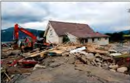
TRULSØY (K2) Fjordingen går ut etter åtte til ni dager. Det er ingen grunn til å tenke på vannlogging eller skade på vegger eller fundament.
