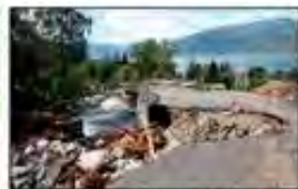
TRULSØY (K2) Fylkesvegen mellom Løkken og Utvik ligger i fullstendig rasert tilstand. Gjennoppbygging for vil ta lang tid. I mellomtiden er det etablert en omkjøringsforstellet i Utvik.
