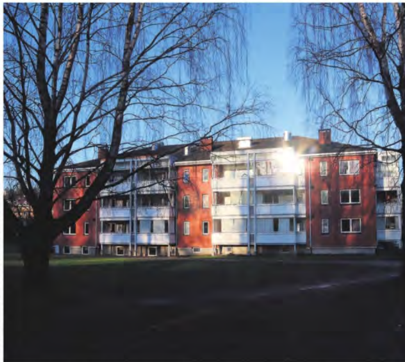
MOFLATAVEIEN 1: Her brant det i romjula og det siste året har politiet hatt over 40 utrykninger til denne blokk.
