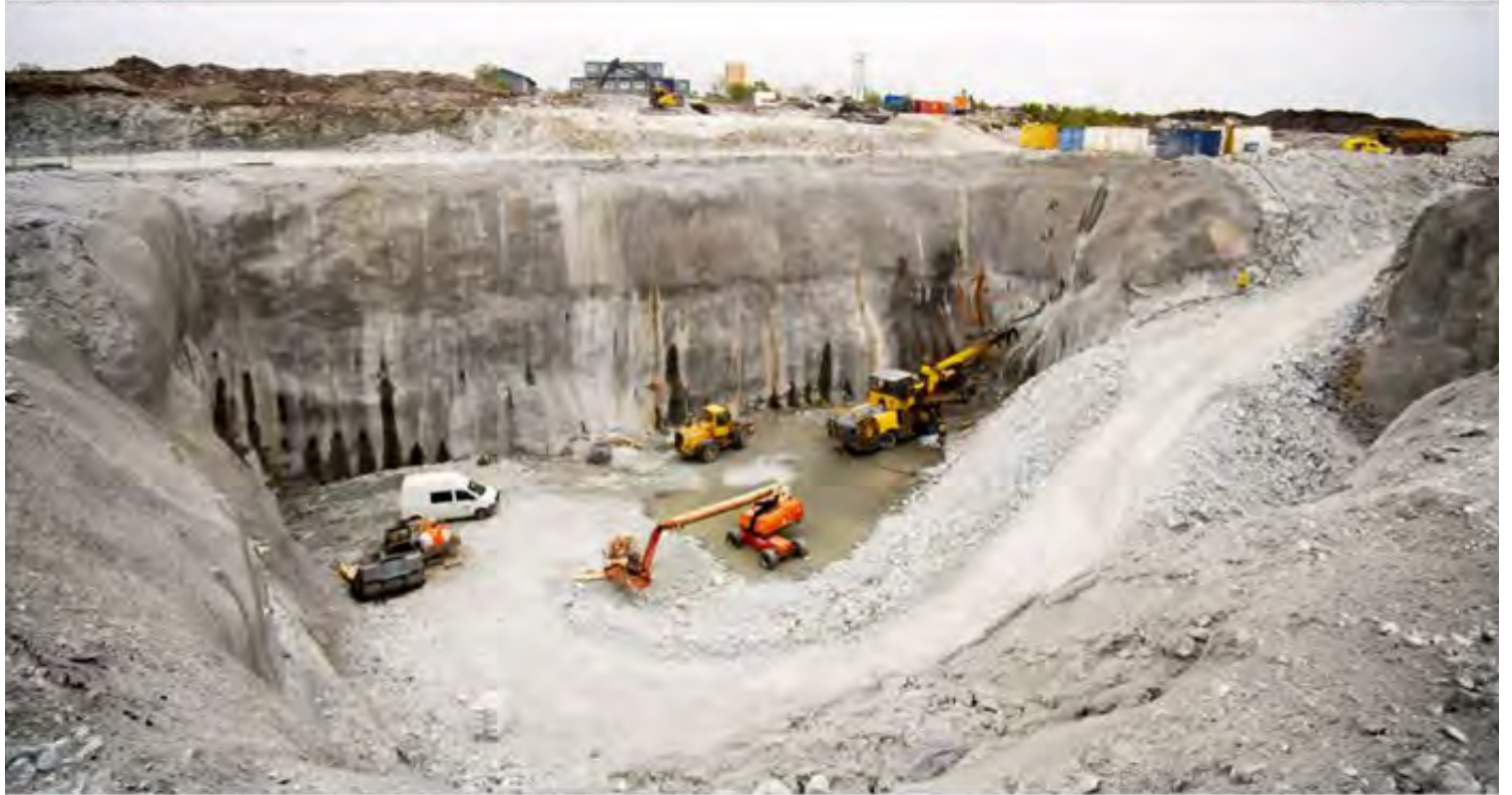
TORE Hordalandsposten: Bygging av og innretning av smolte- og oppdrettstankene på landbasert oppdrettsanlegg for laks i Andfjord Salmon AS er i full gang på Kvernhaugen. Gruppen består av byggere og elektrikerer. (18) TOR HORDALANDSPOSTEN
